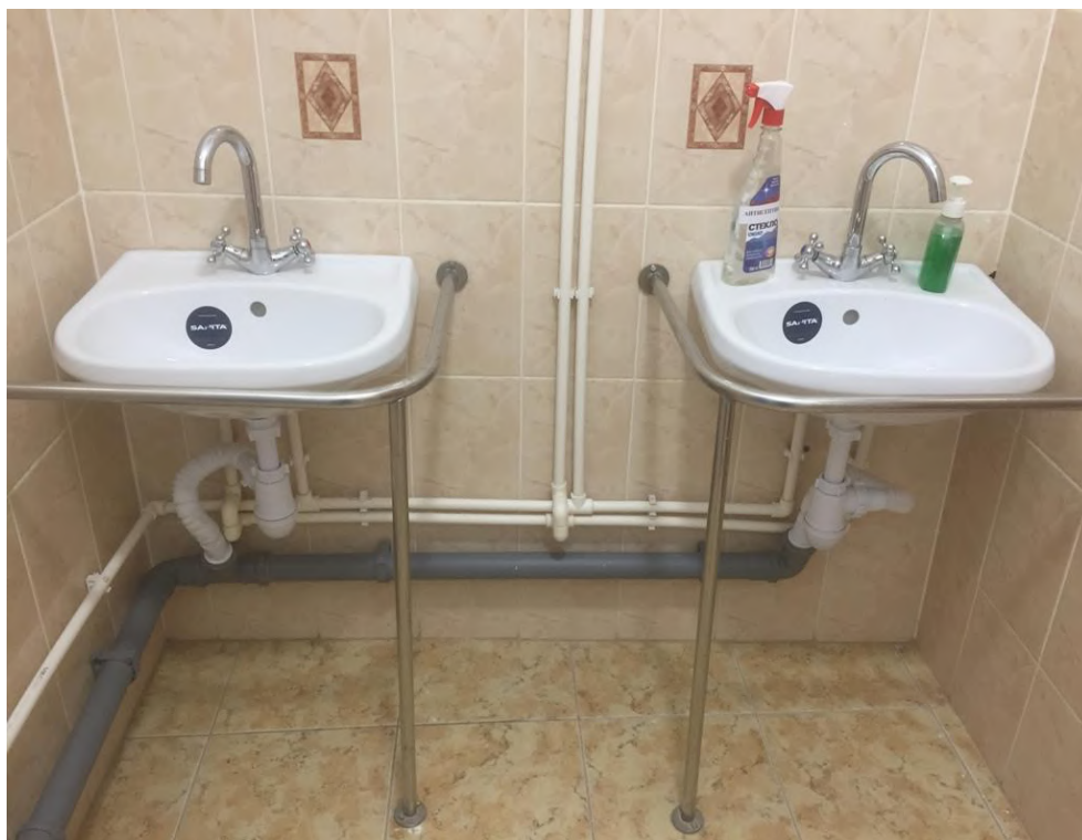
Фото №15 туалетная комната
