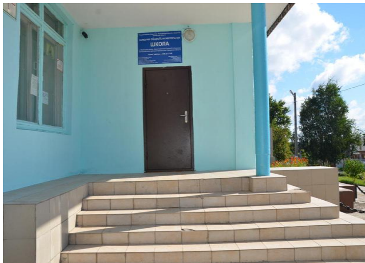
Фото № 3 лестница (наружная)
