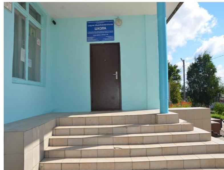
фото № 3 лестница (наружная)
