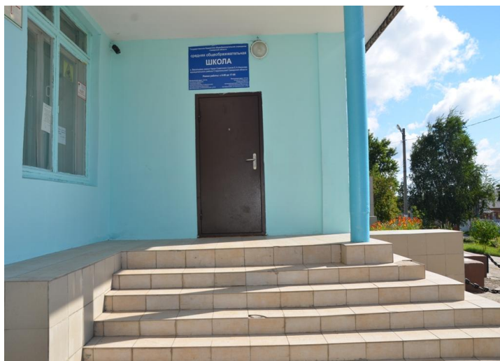
Фото № 3 лестница (наружная)
