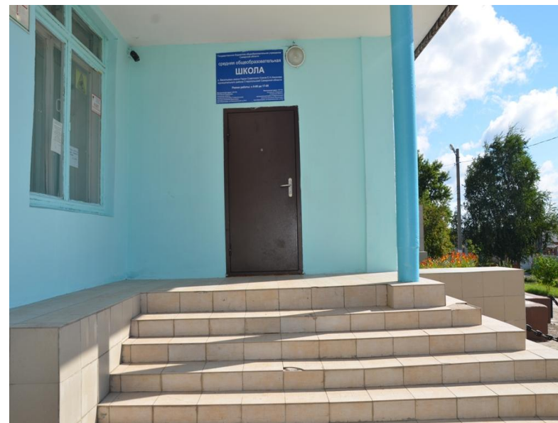
фото № 3 лестница (наружная)
