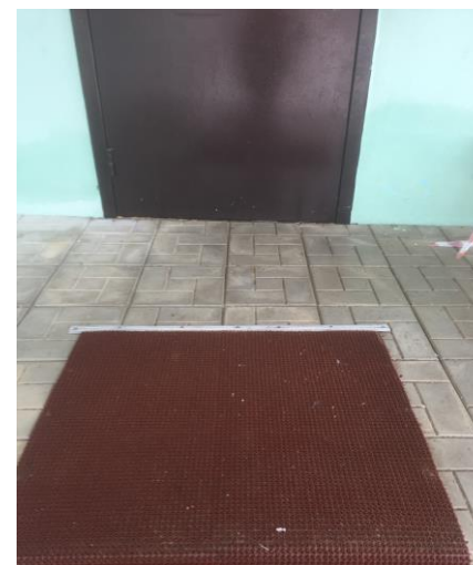
входная площадка перед дверью
