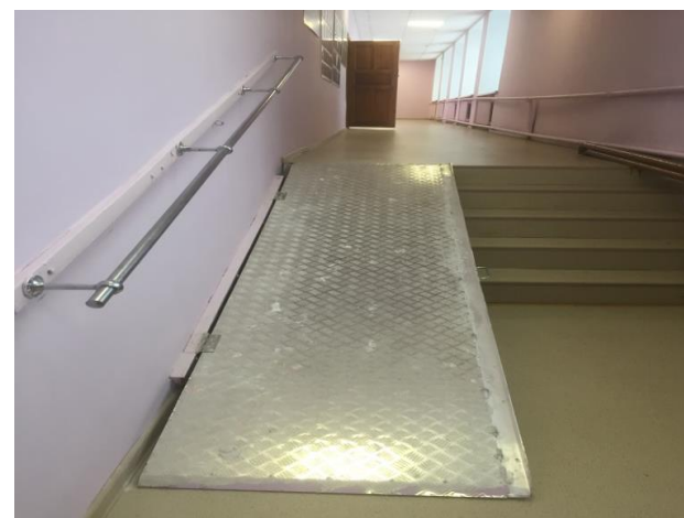
пандус (внутри здания)
