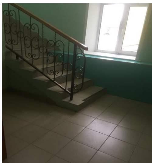
Лестница (внутри здания)
